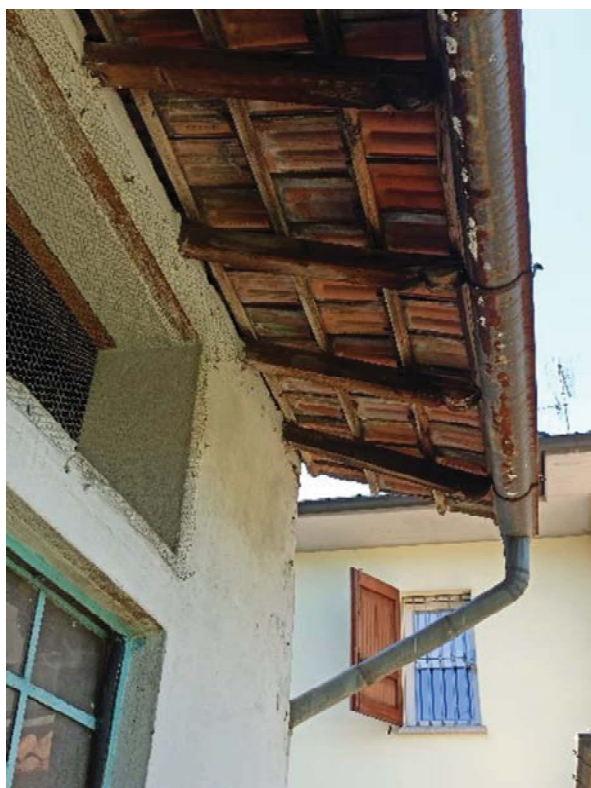
Dettaglio della gronda in aggetto
