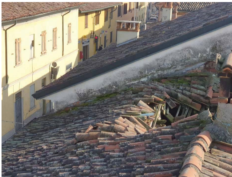
Figura 3: Copertura ceduta falda lato Via Diaz
