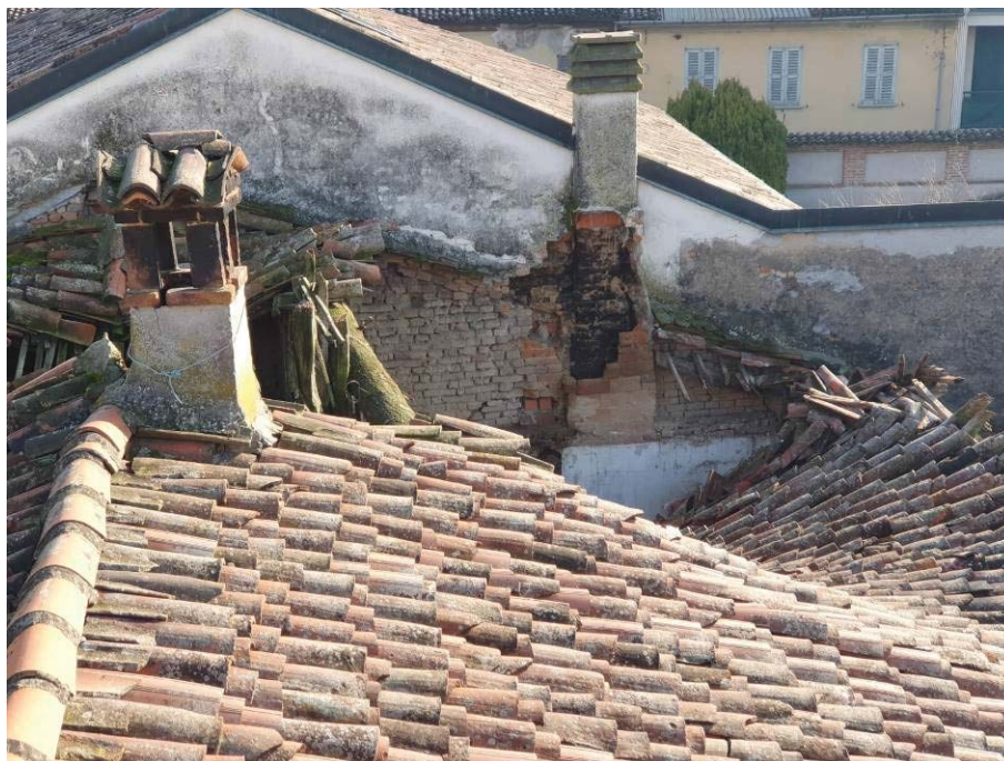
Figura 2: Copertura ceduta falda lato cortile interno
