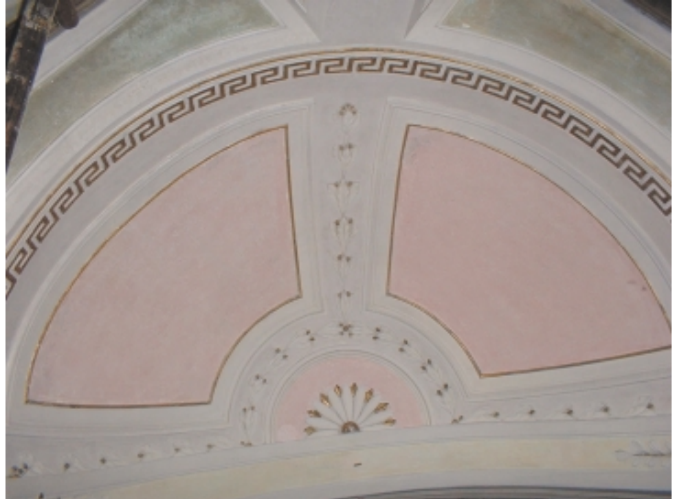
e dopo il restauro
